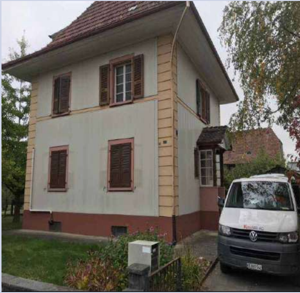
Bild vom ersten Tag der Sanierung
