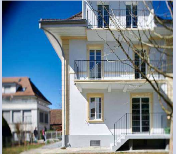
Bilder nach Abschluss der Sanierung
